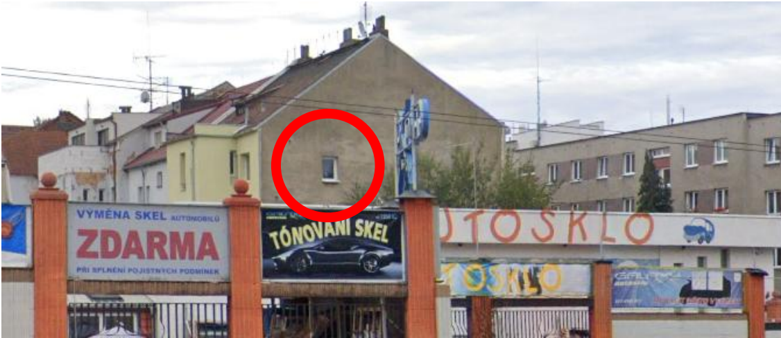
Obrázek č. 10: Objekt č. p. 132 na parc. č. 801 v k. ú. Lobzy, okenní otvor ve štítové zdi
